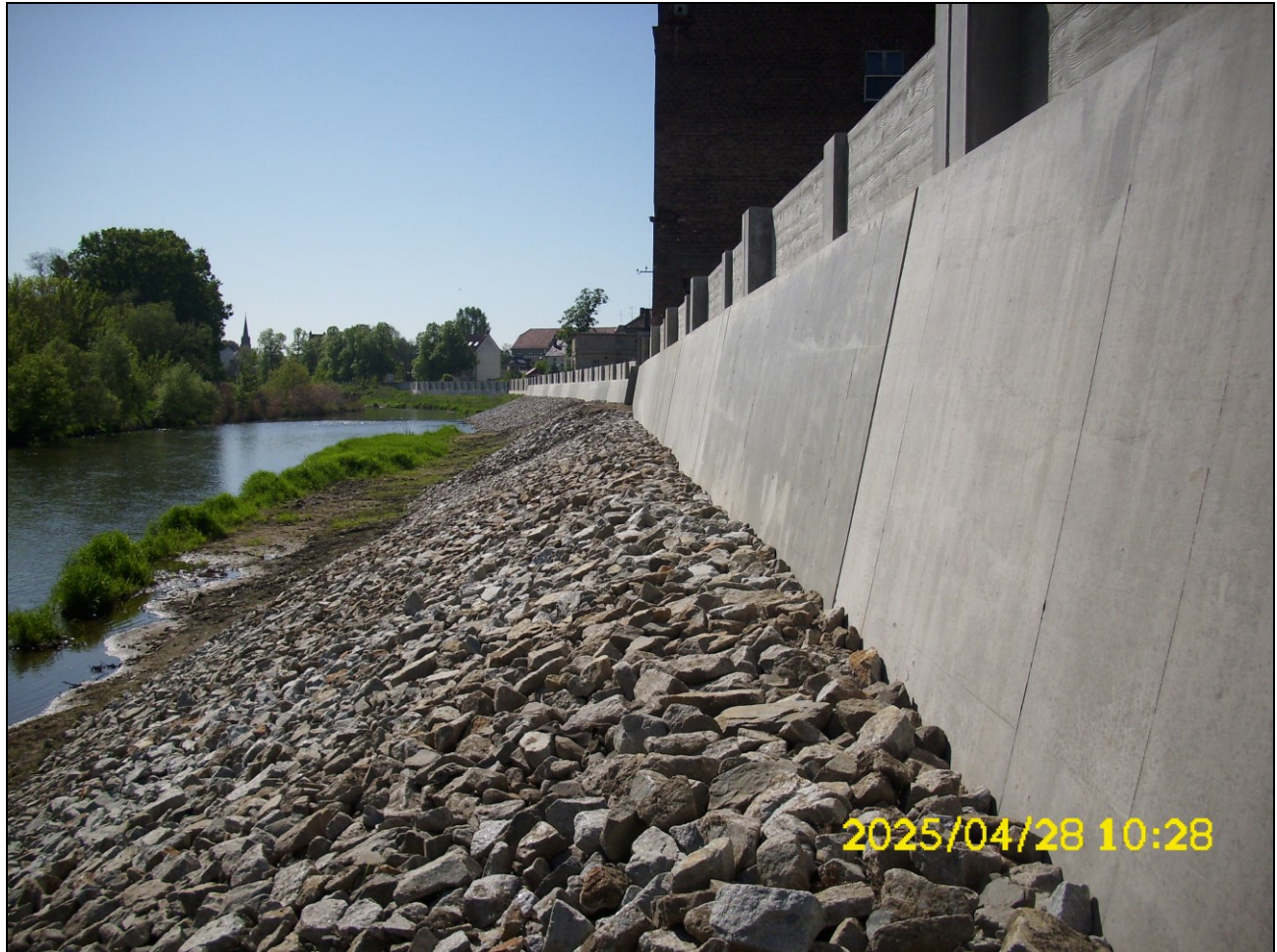
Abbildung 2- fertiggestellte Hochwasserschutzwand mit Vorsatzschale im Teilobjekt 3 inkl. Ufersicherung mit Wasserbausteinen
